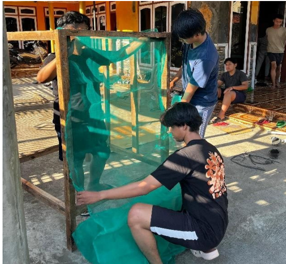
Gambar 2. Proses pemasangan waring
